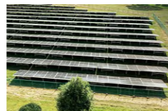
つくば第二工場の太陽光発電設備
